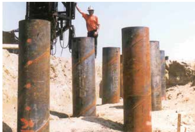
24" x 0.500" spiralweld pipe piles.
